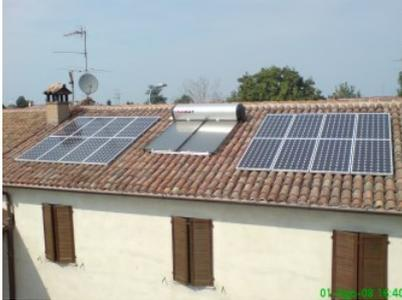
Impianto **fotovoltaico** di potenza nominale pari a **2,80 Kwp parzialmente integrato** abbinato ad impianto **solare termico Solahart 302 Kf** a circolazione naturale realizzati nella **provincia di Cremona**.
